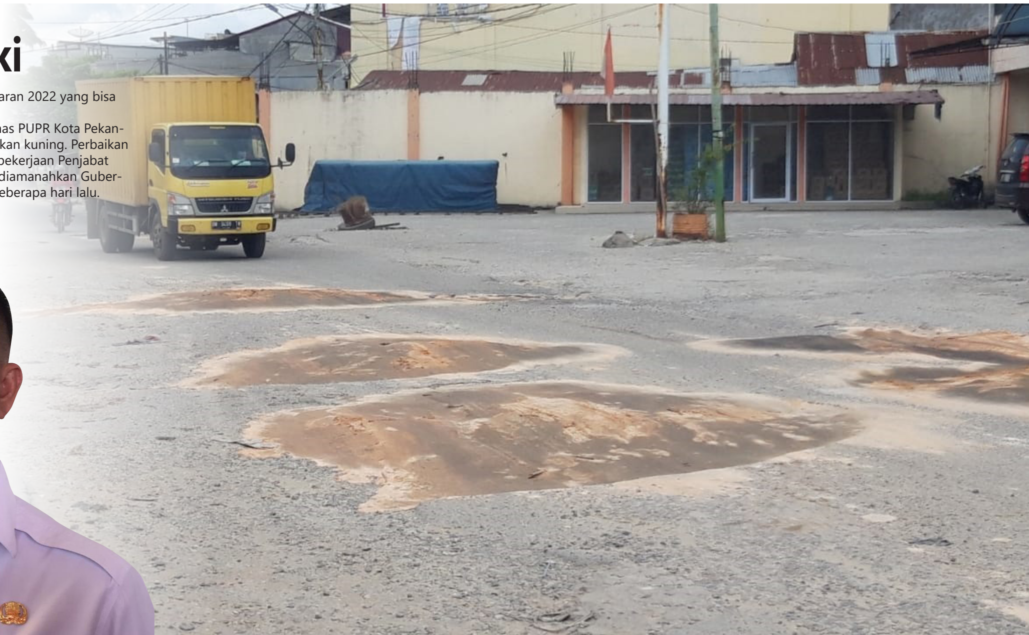
TAMBAL SULAM - Beberapa lokasi ruas jalan rusak dilakukan penimbunan dengan sistem tambal sulam. Terutama di jalan akses yang banyak dilalui masyarakat.
