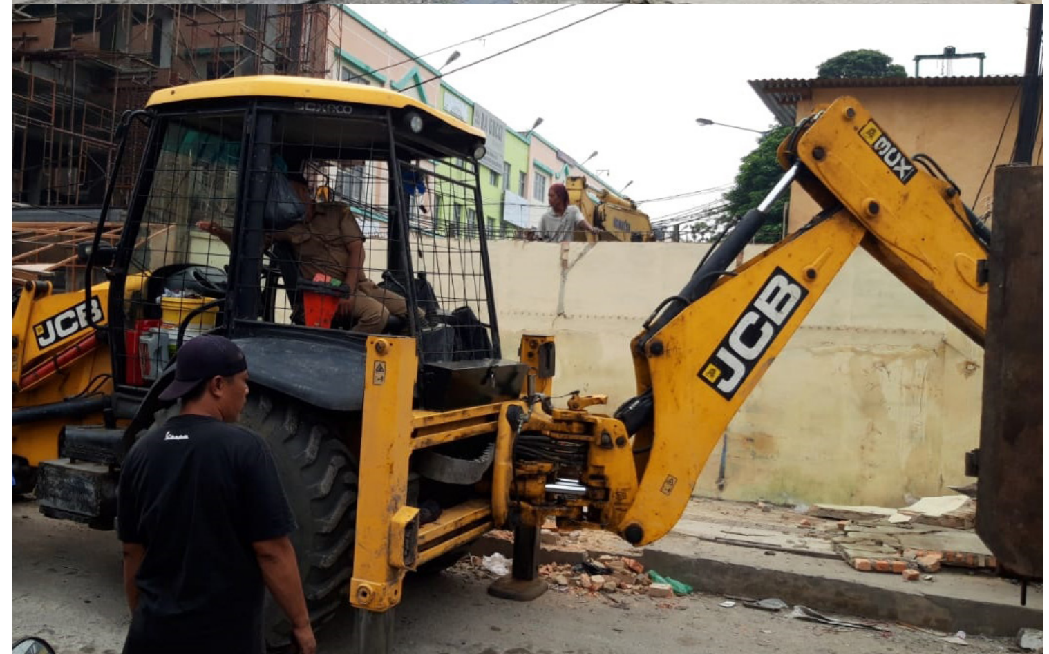
KERAHKAN ALAT BERAT - Alat berat dikerahkan untuk melakukan perbaikan sejumlah ruas jalan rusak di Kota Pekanbaru.
