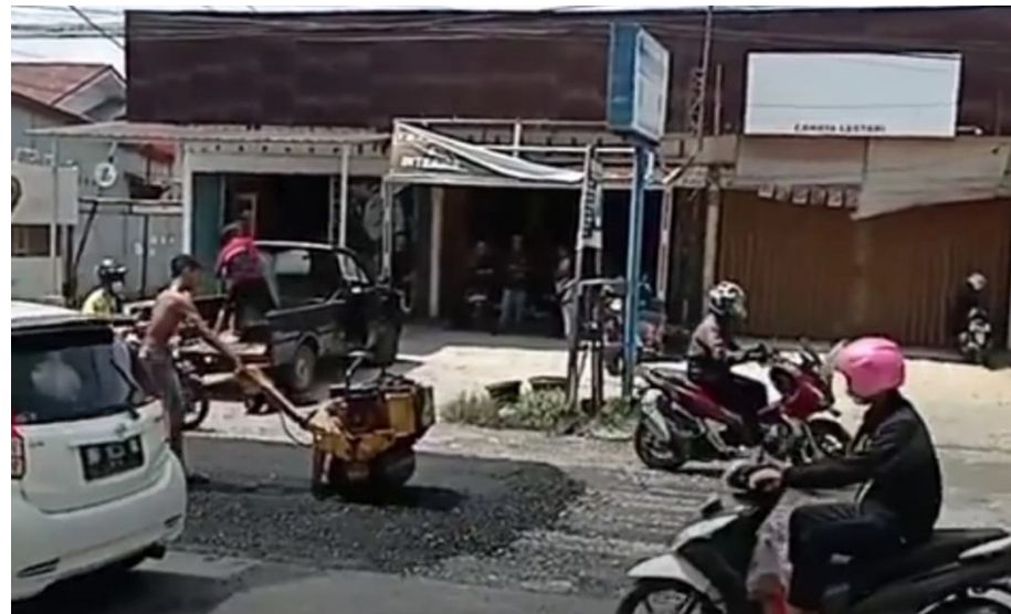
PERBAIKAN JALAN - Pekerja sedang memperbaiki Jalan Delima yang rusak parah, belum lama ini. Perbaikan jalan di kawasan itu termasuk juga drainase.
