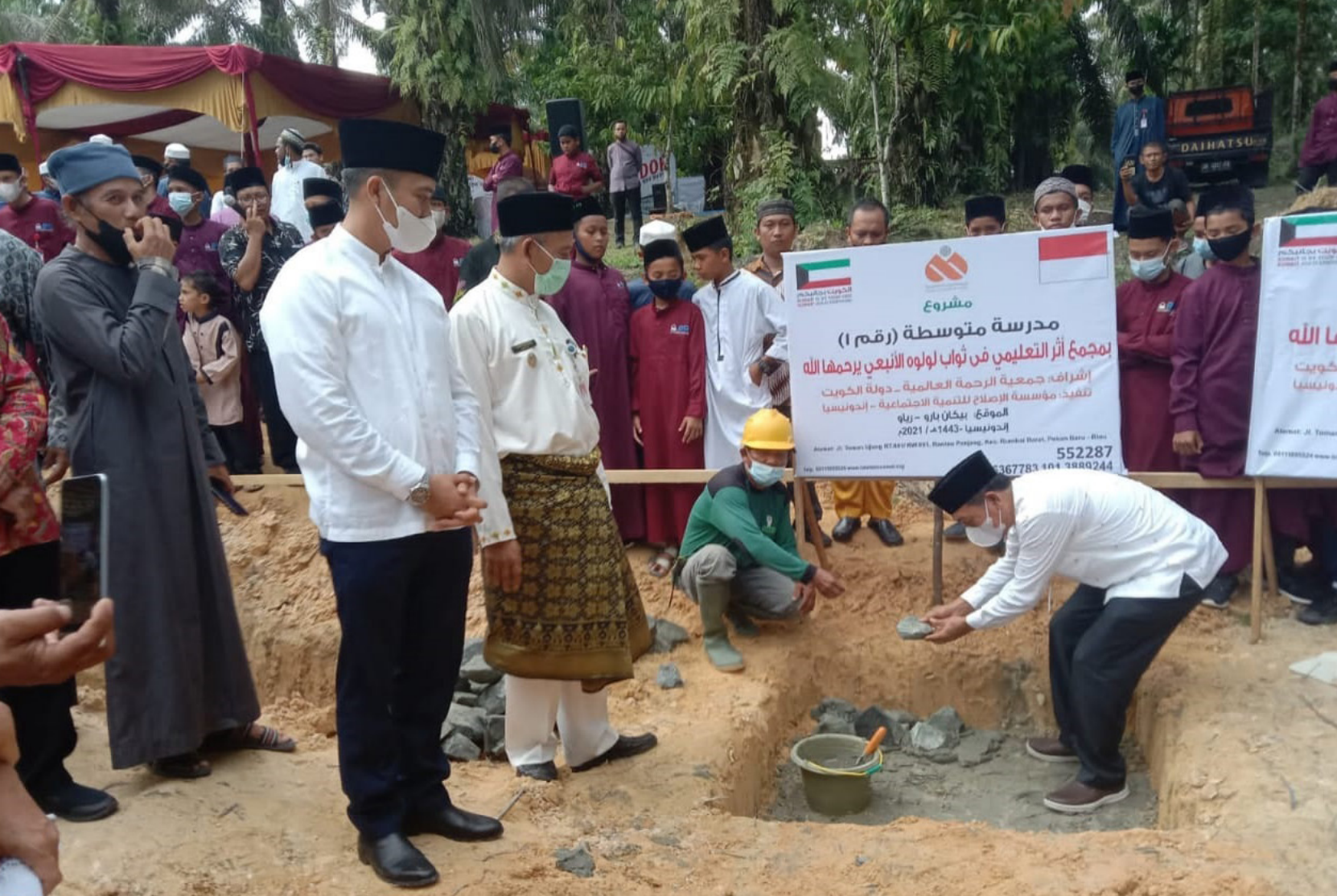
BATU PERTAMA - Camat Rumbai Barat Jsrul meletakkan batu pertama pembangunan Ponpes Baitul Quran Riau di Jalan Toman, Kelurahan Rantau Panjang.
