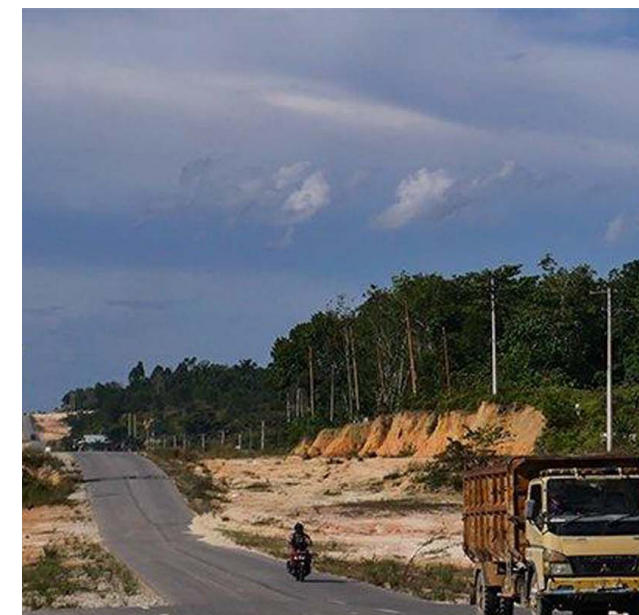
JALAN LINGKAR - Jalan lingkaran luar yang mulai dibangun untuk menghubungkan Kawasan Industri Tenayan dengan pusat Pemerintah Kota Pekanbaru dan jalan tol Pekanbaru-Dumai.
